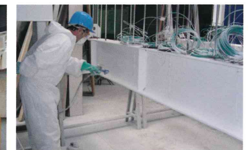
Préparation des profilés pour le passage du PV Coméflamme / Metalflamme
